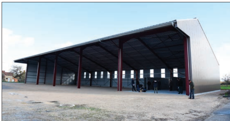
La construction du premier bâtiment de la SAS Solagri 45 a été terminée le 2 décembre.
