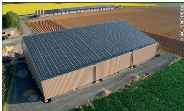
Exemple d'un bâtiment agricole neuf réalisé de A à Z par le groupe Roy énergie.
