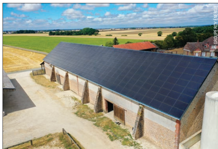
Un exemple d'un bâtiment rénové avec l'installation d'une centrale solaire. Le retour sur investissement est plus long, « dix à quinze ans » selon Romain Roy.
