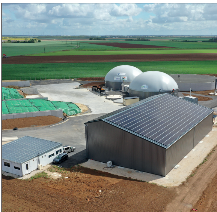
Installation d'un hangar photovoltaïque sur site de méthanisation 130 kWc Autoconsommation - Varize (28)
