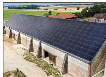
Rénovation de toiture - Après
