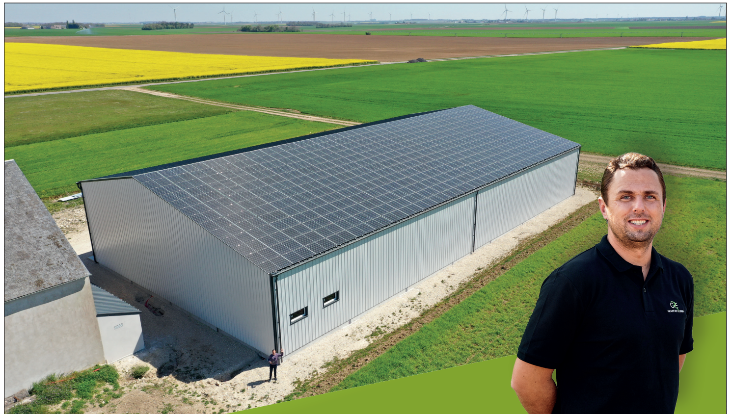
Romain Roy, DG de GROUPE ROY ÉNERGIE - Installation d'une centrale photovoltaïque - 100 kWc Revente - Outarville (45)
