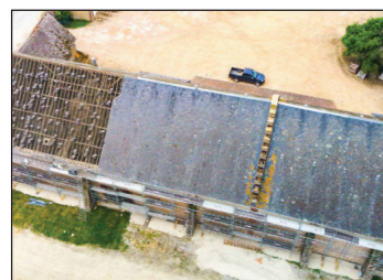
Rénovation de toiture - Avant
