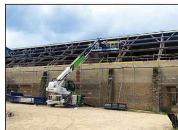
Rénovation de toiture - Pendant
