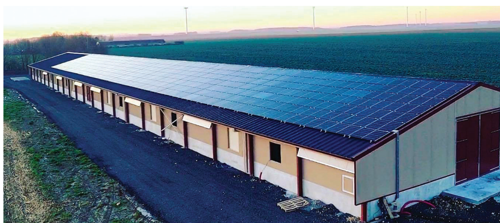
Centrale photovoltaïque de 100 kWc sur un poulailler d'Eure-et-Loir
