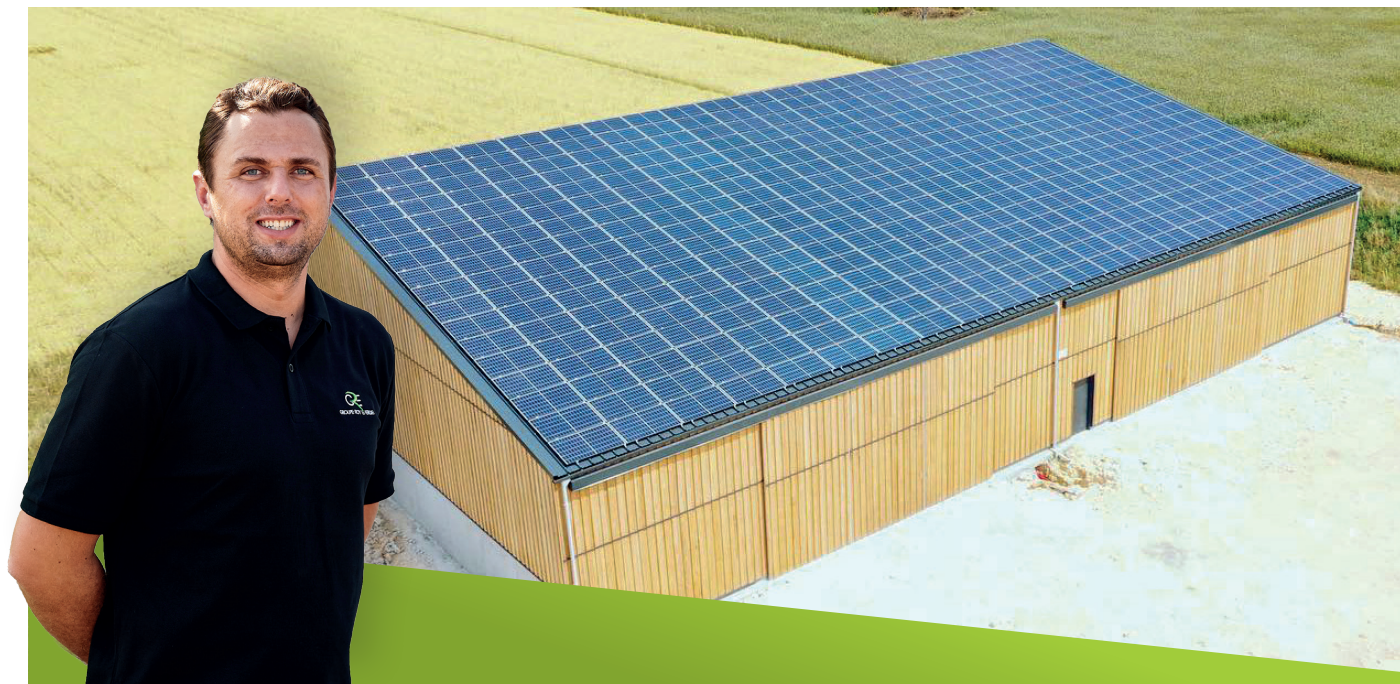
Romain ROY, DG de GROUPE ROY ÉNERGIE - Centrale photovoltaïque de 100 kWc
