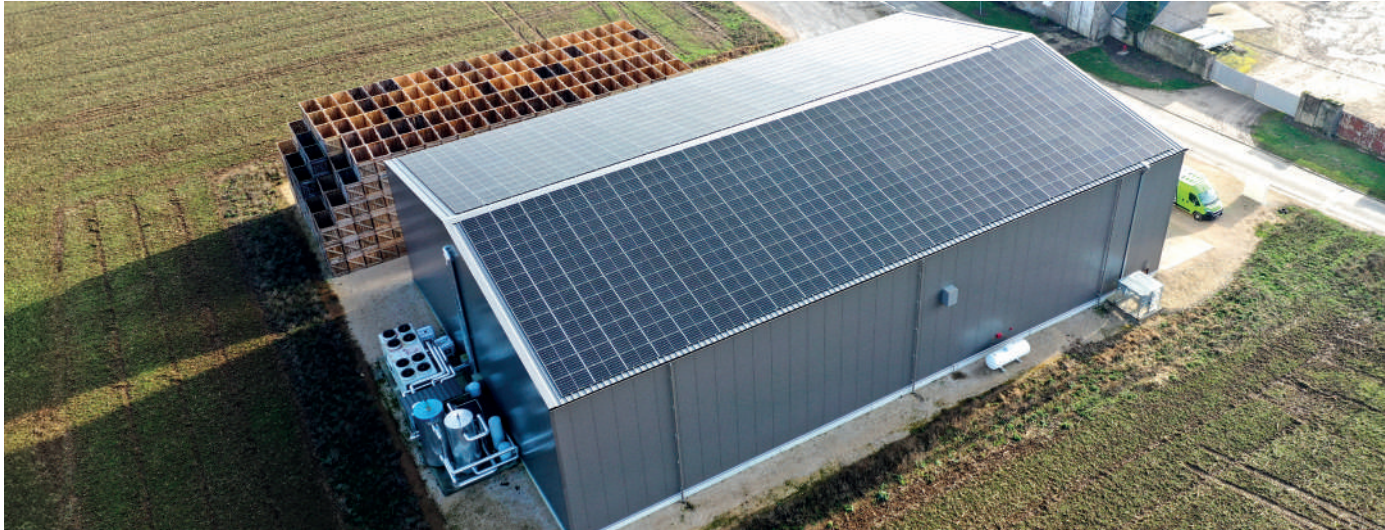
Bâtiment agricole 234 kWc - Loiret
